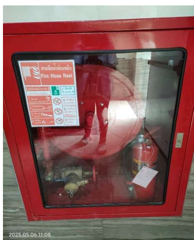
ภาพที่ 35 แสดงตู้ดับเพลิง (Fire Hose Cabinet)
