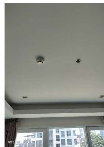
ภาพที่ 36 แสดงอุปกรณ์ดับควันและหัวกระจายน้ำดับเพลิง
