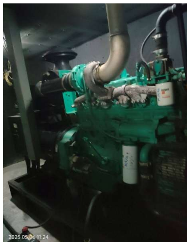
ภาพที่ 41 แสดงเครื่องกำเนิดไฟฟ้าสำรอง
